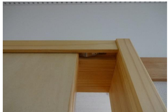
写真9 フラットレール用ストッパーの位置で扉がいったん止まるようになっている
