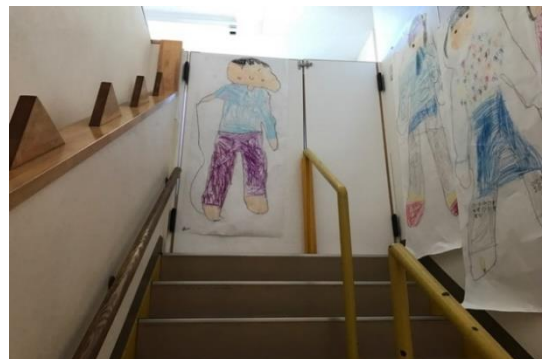
写真10 階段の上部の柵
