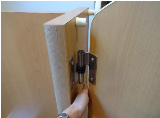
写真7 隙間が大きく、指をはさまない構造のドア2
