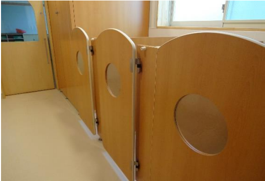
写真6 隙間が大きく、指をはさまない構造のドア1
