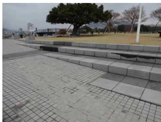
写真 13. スロープと階段を合体させた作り (長崎港)
