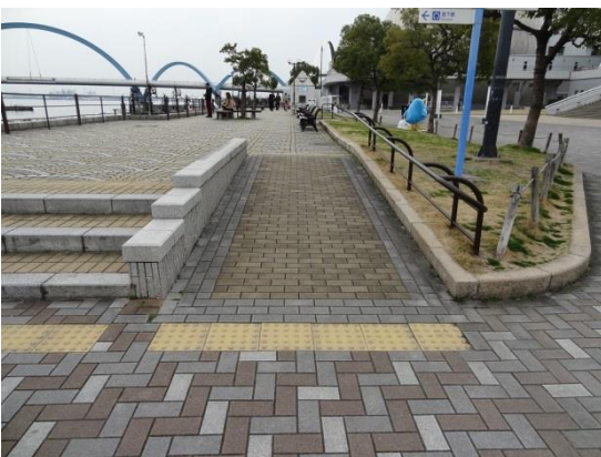
写真 9. スロープの始終に設置された 点字ブロック (名古屋港)
