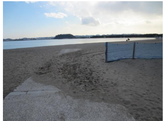
写真 23. 砂浜に設置されたコンクリートの通路（八景島・海の公園）
