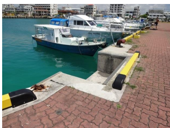
写真 18. 船の乗り場入り口に点字ブロックがないために視覚障害者が転落する危険性がある（石垣港）
