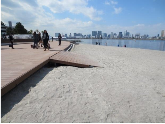
写真 26. 遊歩道から砂浜に降りるためのスロープ（お台場海浜公園）
