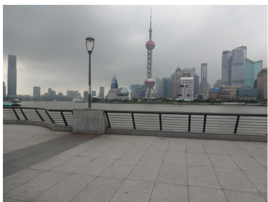
写真 20. 細いフレームが使われた柵を設置することによって、車いす使用者などが景色を見やすい（上海）
