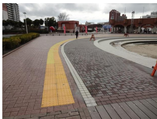
写真 12. 不必要な箇所に設置された点字ブロック (清水マリニパーク)
