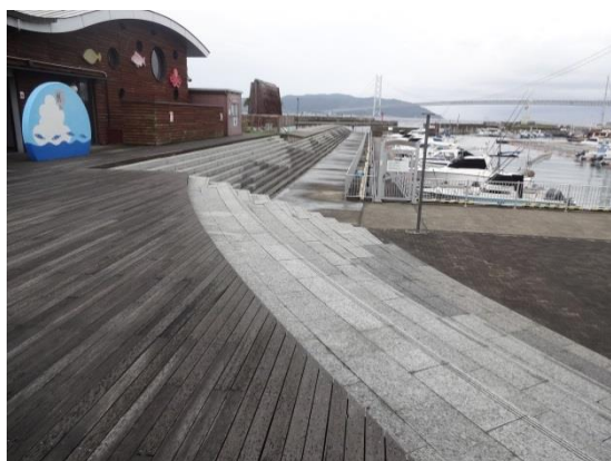
写真 11. 階段の始まりと踏面の色が異なる場合に、段差を視認しやすくなる (マリニピア神戸)
