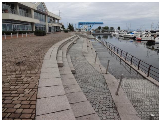
写真 14. 蹴上が高いが、途中に足置を設置する箇所がある（小樽）
