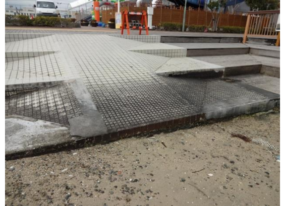
写真 6. 砂浜の砂が移動したために段差が できてしまう (清水マリパーク)
