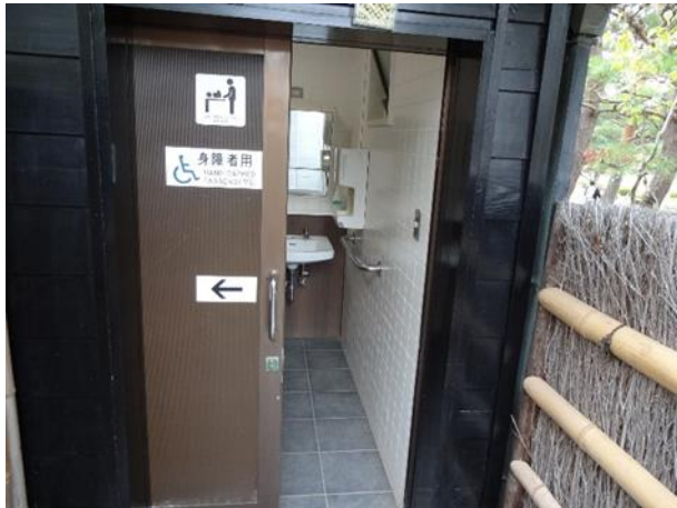
写真 15. 多目的トイレのドアが重く、長さの短いループ状の取っ手がついている：要改善事例 松本城（長野）
